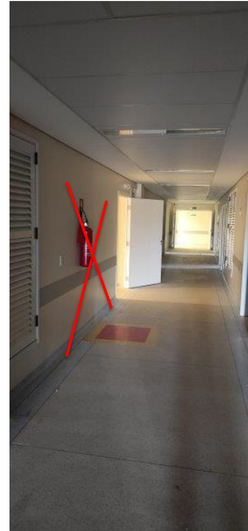
Local onde será aberto vão para acesso a sala
